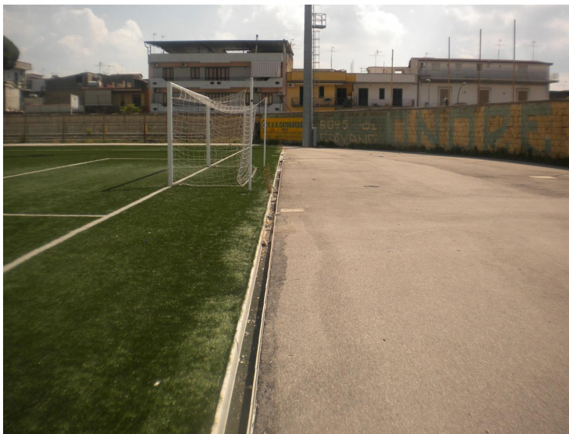
La porta di calcio, lato Cardito, e la canalina per il drenaggio dell'acqua del campo.
